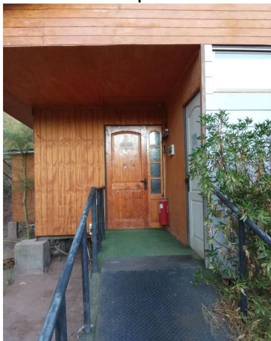
Fotografía 18: Rampa de acceso a baño y sala de exposiciones
