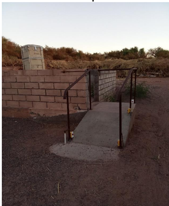
Fotografía 17: Rampa de acceso a telescopios
