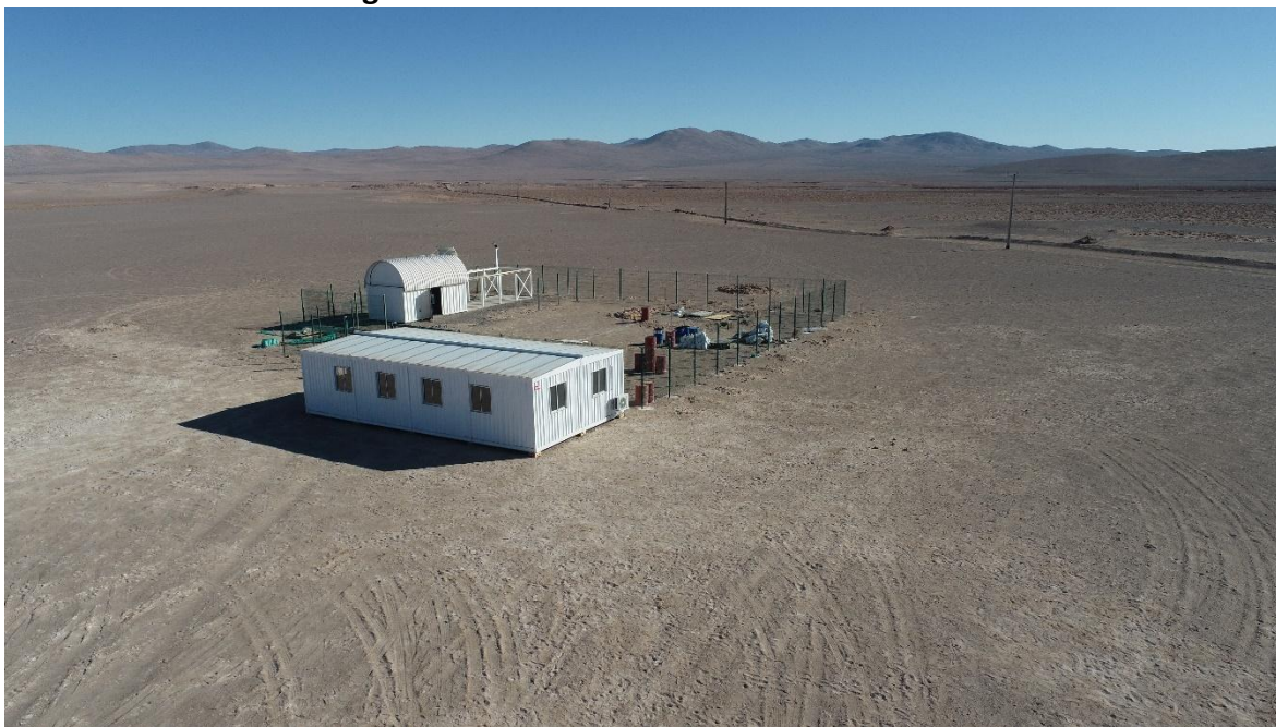
Fotografía 1: Vista Panorámica del observatorio.
