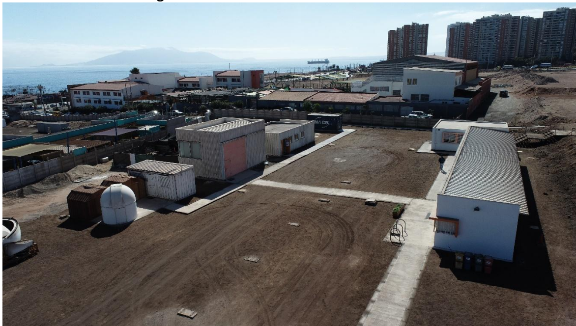
Fotografía 3: Edificios de la Unidad de Astronomía.
