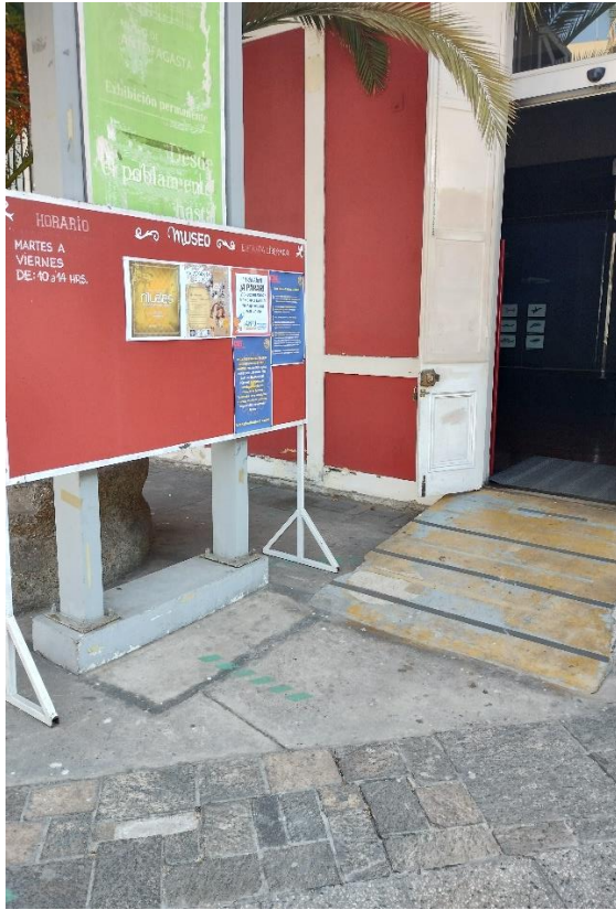
Fotografía 11: Rampa de acceso
