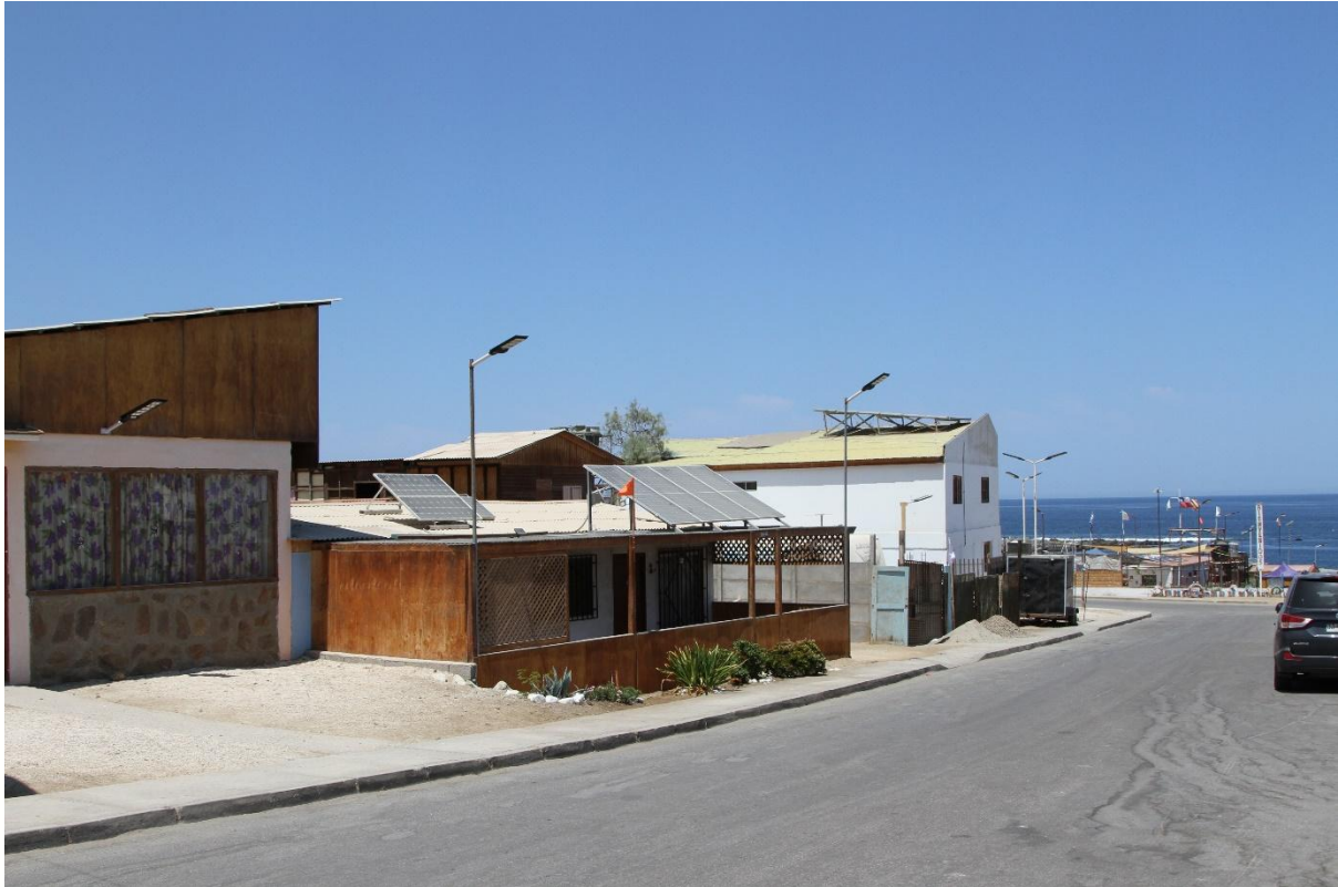
Fotografía 8: Paneles Solares en Caleta Buena
