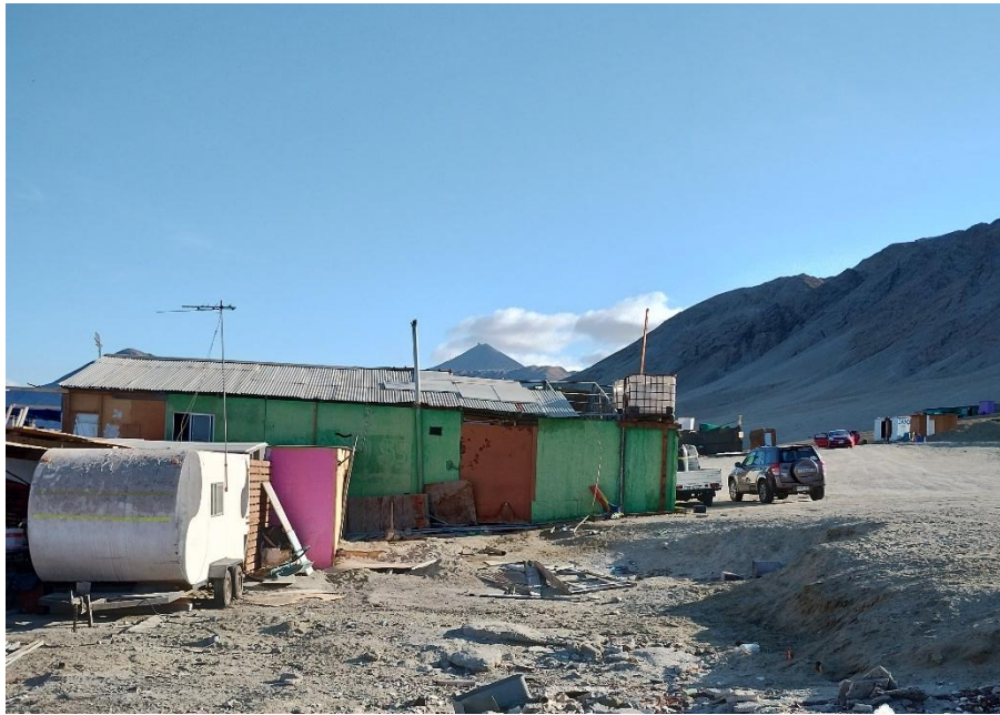
Fotografía 3: Copa de agua en vivienda de Caleta Punta Cuartel
