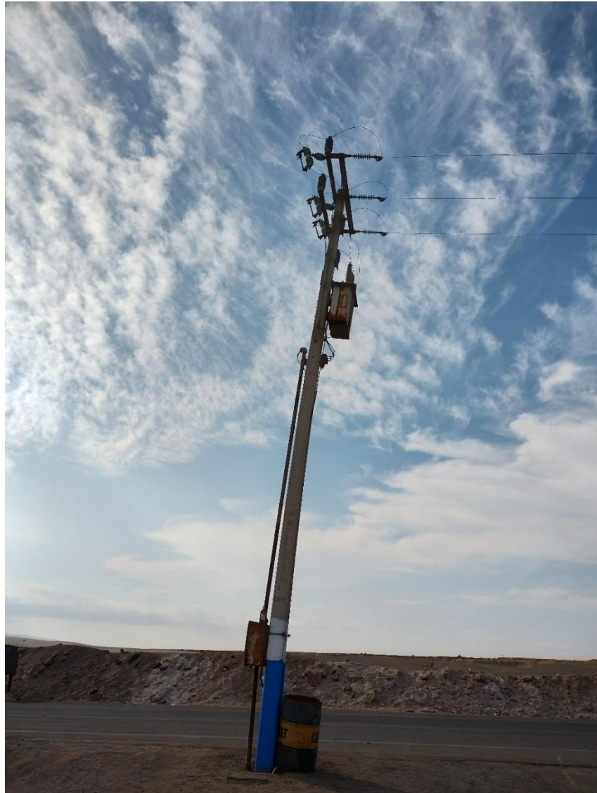
Fotografía 4: Torre de electricidad cercana al área protegida
