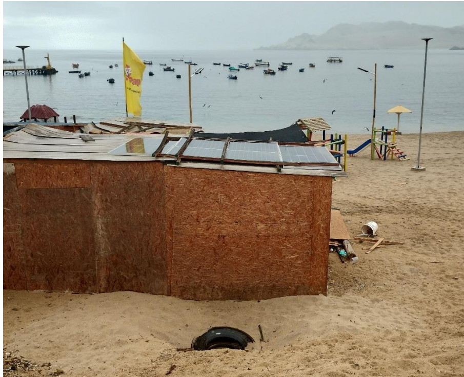
Fotografía 7: Paneles solares en una vivienda de Caleta Cifuncho.
